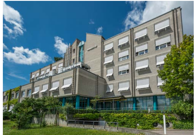
Novotechnik Ostfildern-Ruit, Produktionsgebäude
